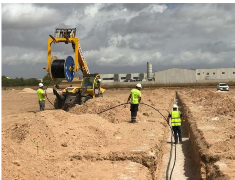
Útil de tendido mediante manipulador tipo 2.
